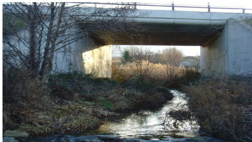
Pont du TGV sur la Mandré: un passage favorable à la faune.
