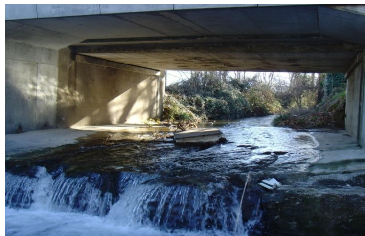
Seuil sous le pont passant l'Ecoutay, aux Dorelons.
